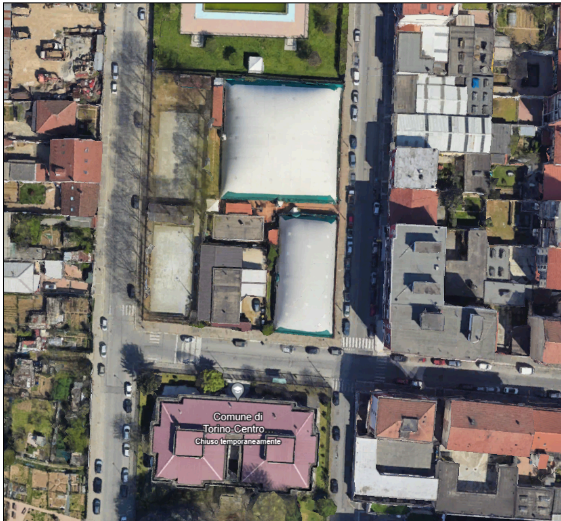
Vista impianto da Google earth
