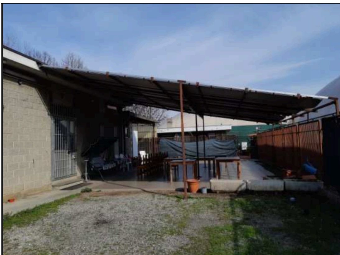
Vista generale impianto
